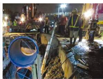
敲除漏水管線
