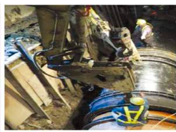
管線裝接完成
