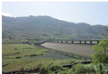
大溪區後慈堰沿線巡查
