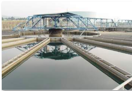
高速膠凝(污泥毯)沉澱池
