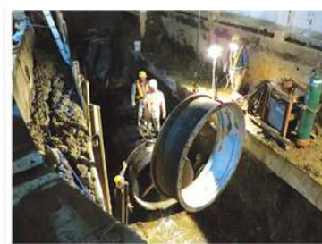
吊放套管及安裝
