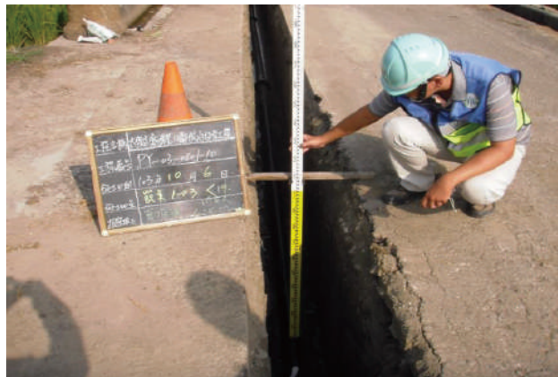
嘉義太保市新埤里供水延管工程
