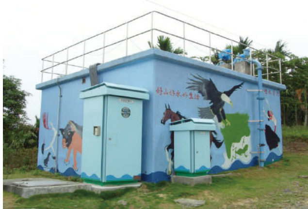
雲林古坑鄉華南地區供水延管工程(機電部份)
