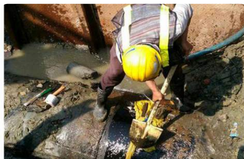
降低裂縫處漏水量及水花噴濺
