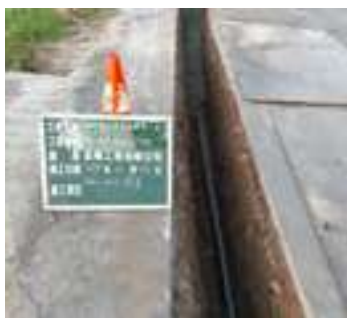
大雅區員林里供水延管工程 施工照片
