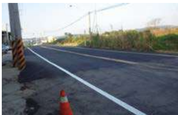
路面回復完成
