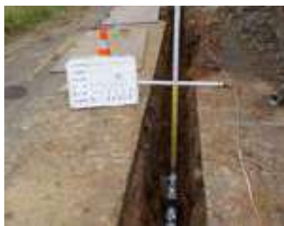
楊梅區上湖里楊湖路二段 719 巷 640 弄供水延管工程 - 埋管照片
